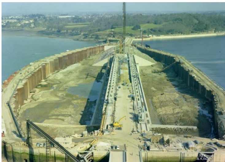
mise à sec du chantier de la Rance
