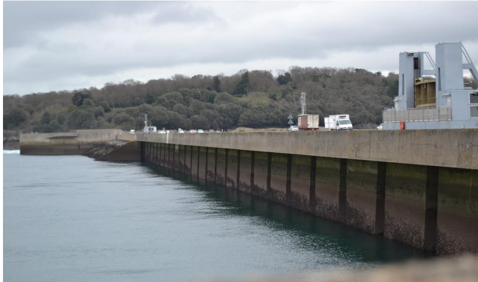
usine marémotrice de la Rance
